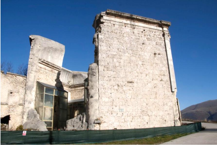
Fig. 7: Santuario della Madonna della Neve a Castel Santa Maria di Cascia dopo il crollo, visibile la struttura di protezione in plexiglas degli affreschi superstiti, che non è stata sufficiente a proteggerli dalle intemperie
