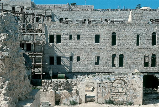
Figg. 4-5: Gerusalemme. Edifici in cemento armato rivestiti in elementi lapidei di piccolo spessore condizionano l'architettura di molte aree del Vicino Oriente in netto contrasto con l'architettura *all stone* che, invece, caratterizza l'edilizia tradizionale.
