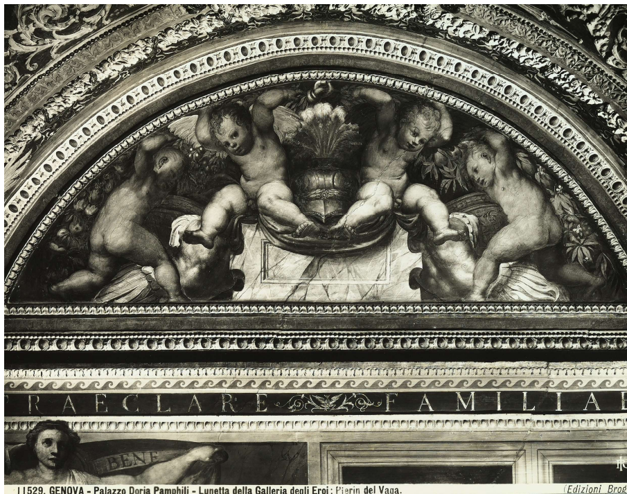
Fig. 6: Detail of a vault, Loggia degli Eroi, Palazzo Doria, Genoa (Photo Taddeo, per gentile concessione di Amministrazione Doria Pamphilj s.r.l.)
