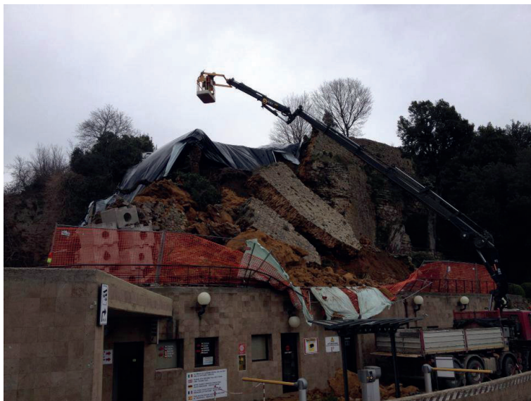
Fig. 5: Volterra 3 marzo 2014: lo sperone di Piazza Martiri della Libertà sta crollando (© Aiuta Volterra www.aiutavolterra.it )
