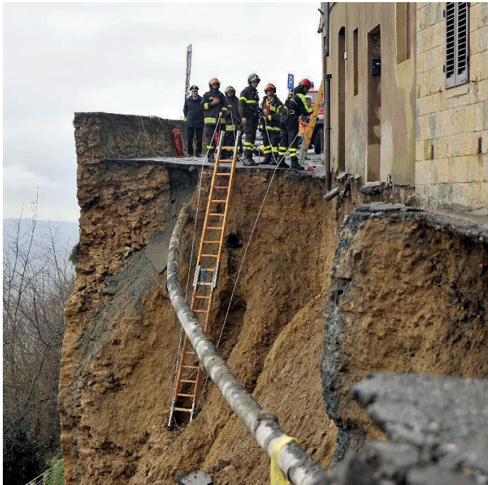
Fig. 4: Volterra, via Lungo le Mura, i Vigili del Fuoco al lavoro sul versante ovest il 31 gennaio 2014 (© Aiuta Volterra www.aiutavolterra.it )
