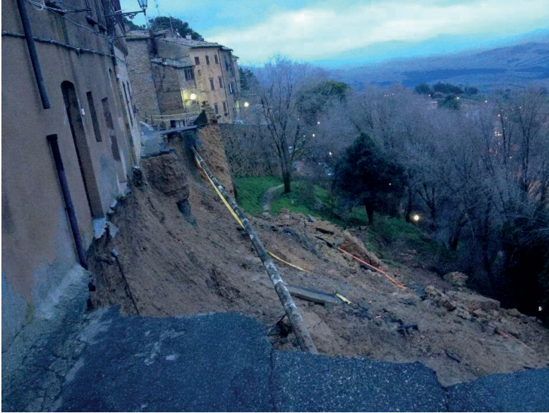
Fig. 1: Volterra, frana di via Lungo le Mura all'alba del 31 gennaio 2014 (© Aiuta Volterra www.aiutavolterra.it )
